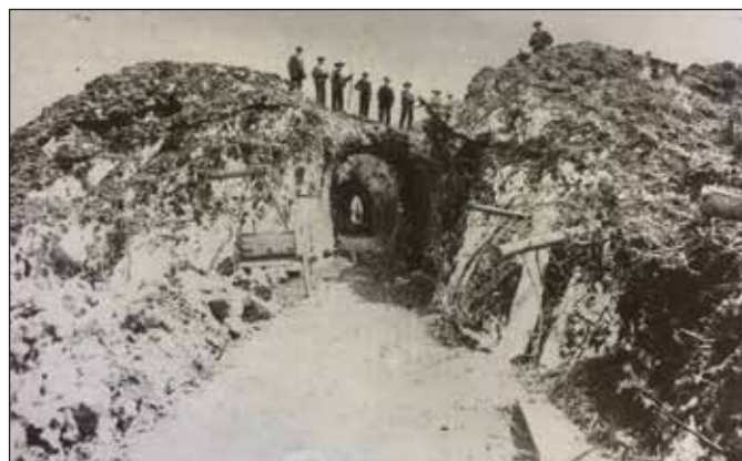
La galleria lunga 150 metri scavata sotto la valanga per ristabilire le comunicazioni (1888).
