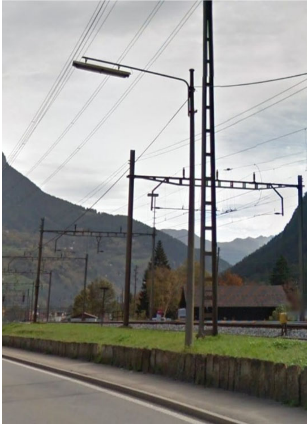
Via San Gottardo - esempi illuminazione esistente in sostituzione
