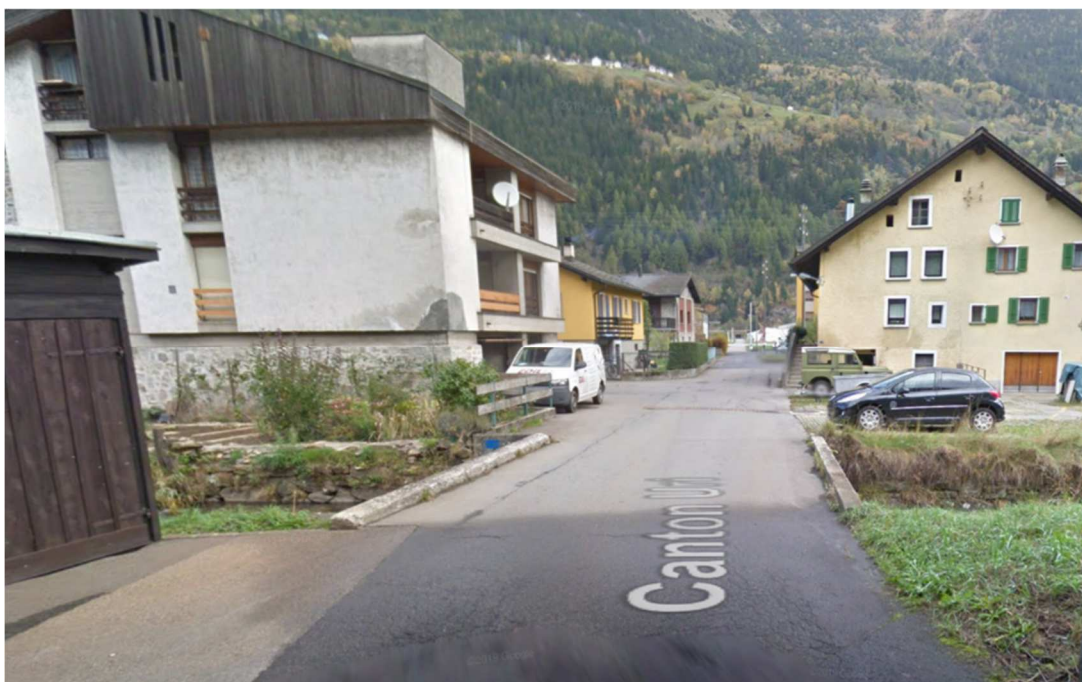
L'imbocco al "Canton Uri" nei pressi del sottopasso ferroviario. In primo piano il ponte su "Rio Secco"
