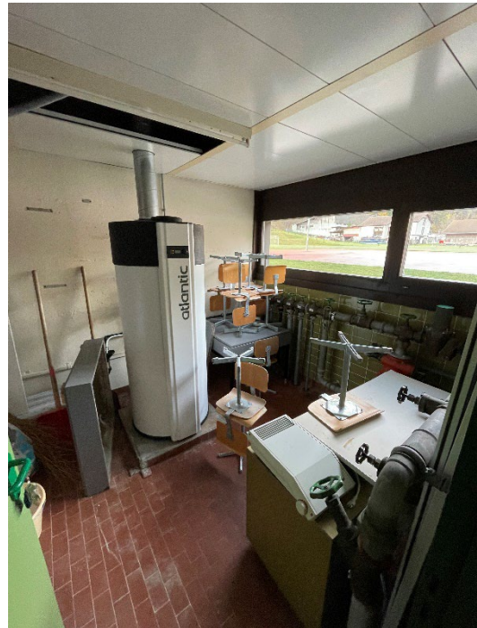
Blocco 3 centrale elementari
